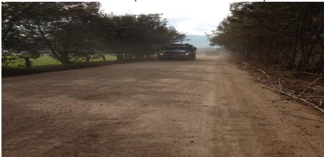
Ilustración 29. Transporte del material arcilloso en volquetas
